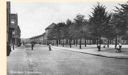
De Van Swindenstraat bij het Edisonplein, in 1935. Het plein markeerde de rand van het Singelkwartier, met centraal de markante Theo Thijsenschool uit 1920 en aan twee zijden woningen. Links de nieuwbouw, met een duidelijk stedelijker uitstraling.
