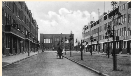
De Boerhaavelaan, met aan het eind het pompstation aan de voet van de Rotterdamsedijk
